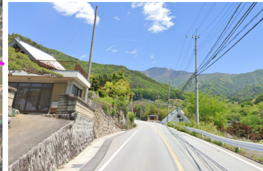
一般国道 411号 (第一次緊急輸送道路)
