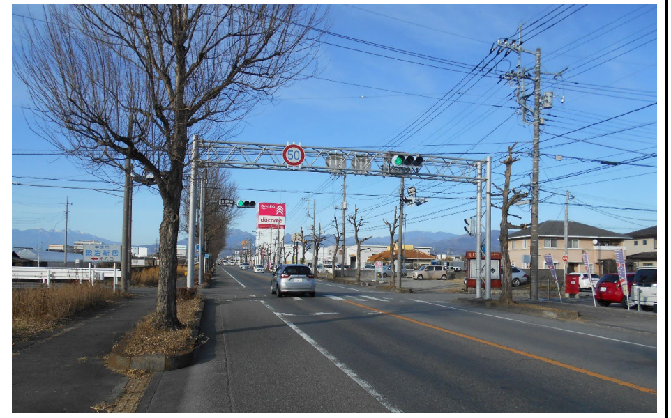
【写真②】 災害時に倒壊の恐れのある電柱
