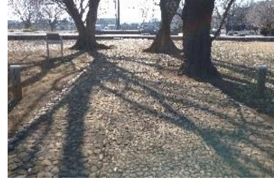
写真9 瓦片の一部を使用した史跡武蔵国分寺跡 (国分寺市) の堂間通路整備
