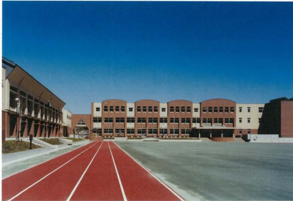
西側から校舎の全景
