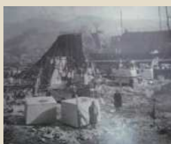
建設中の謝恩碑
