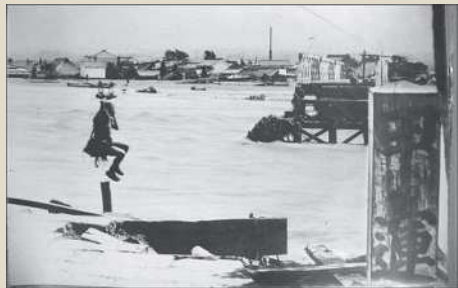
明治40年の大水害の状況（笛吹市甲運橋）
