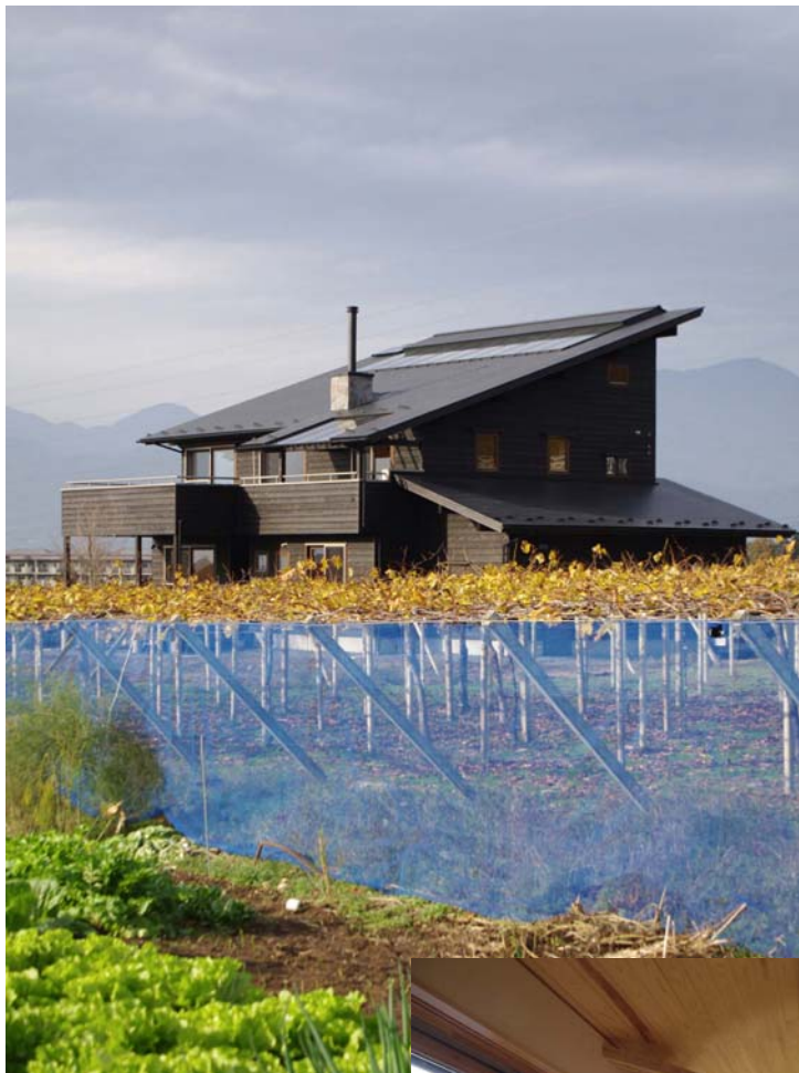
北東側からの全景
