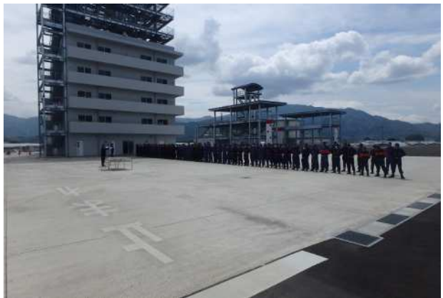
全天候型放水訓練施設
