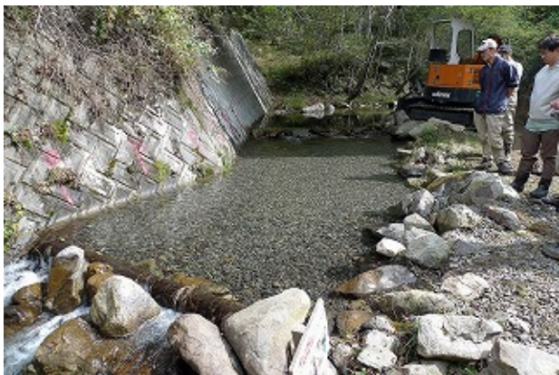
写真 日川支流に整備した人工産卵場（10月）
