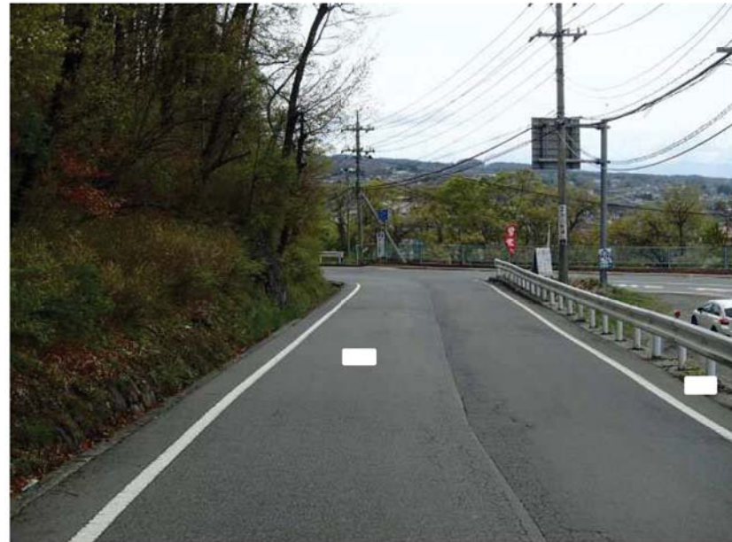
④ 幅員狭小箇所
