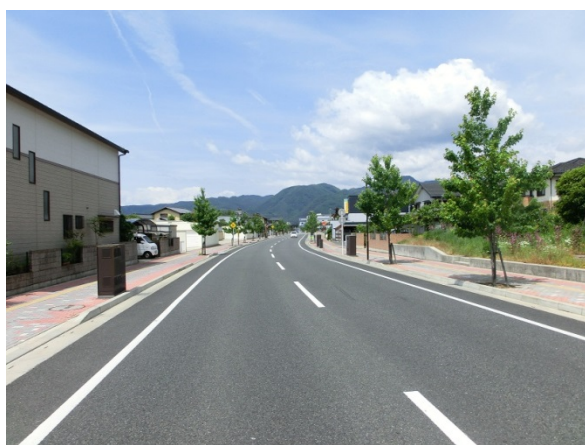
<風土を創る> 周囲の景観に配慮した街路整備 (写真：1.3)
