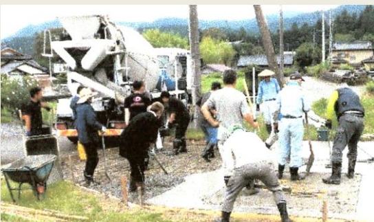
防火水槽上コンクリート打設
