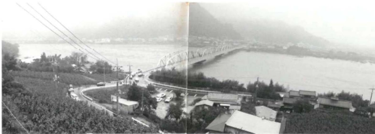
富士橋付近の洪水時状況(昭和57年台風10号)
