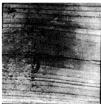
図3 スギ材の劣化状況
