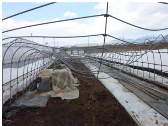
単棟パイプハウスのM字型陥没
