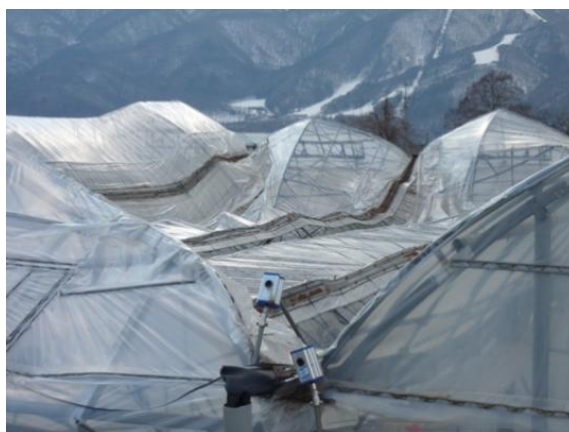
連棟パイプハウスの倒壊
