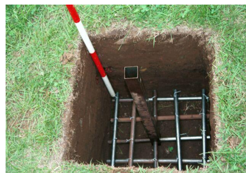
パイプによる基礎部の補強*
