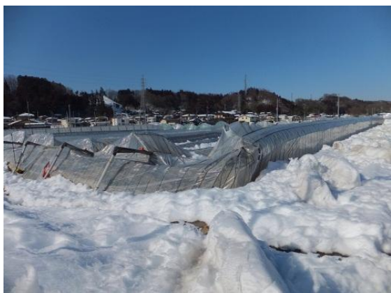
連棟パイプハウスの倒壊
