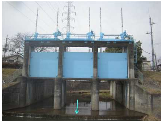
水門(コンクリート駆体部)
