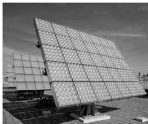
集光型太陽光発電システム ( 例 )
