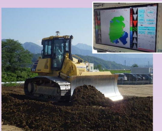
■MGブルドーザによるICT施工
