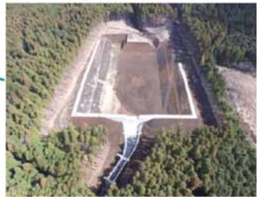
■富士山砂防堰堤整備の例
