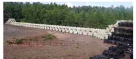
■ブロック堰堤緊急施工事例(浅間山)
