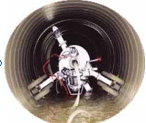
管路の更生工実施
