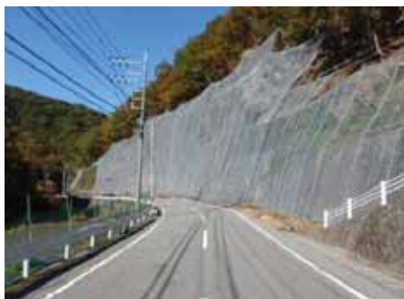
落石防護網工
