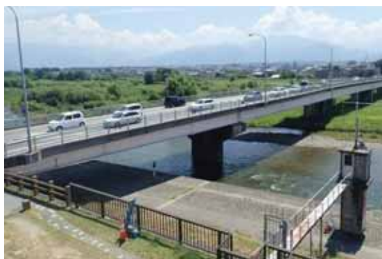
■耐震補強工事実施予定箇所 (消防本部と接続する(一)石和温泉停車場線 鵜飼橋)
