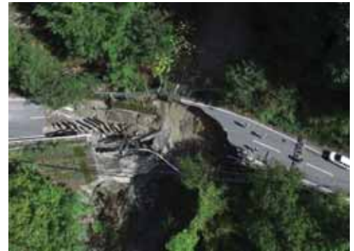
(主)南アルプス公園線(早川町湯島)
