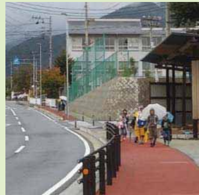
■安全対策が実施された通学路
