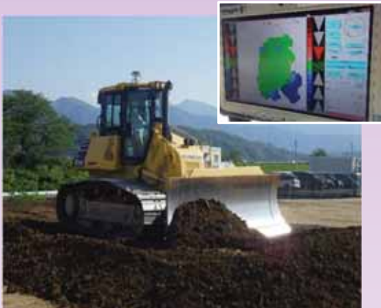
■MGブルドーザによるICT施工
