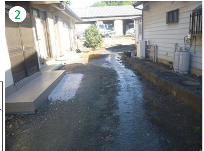
H26 漏水状況
