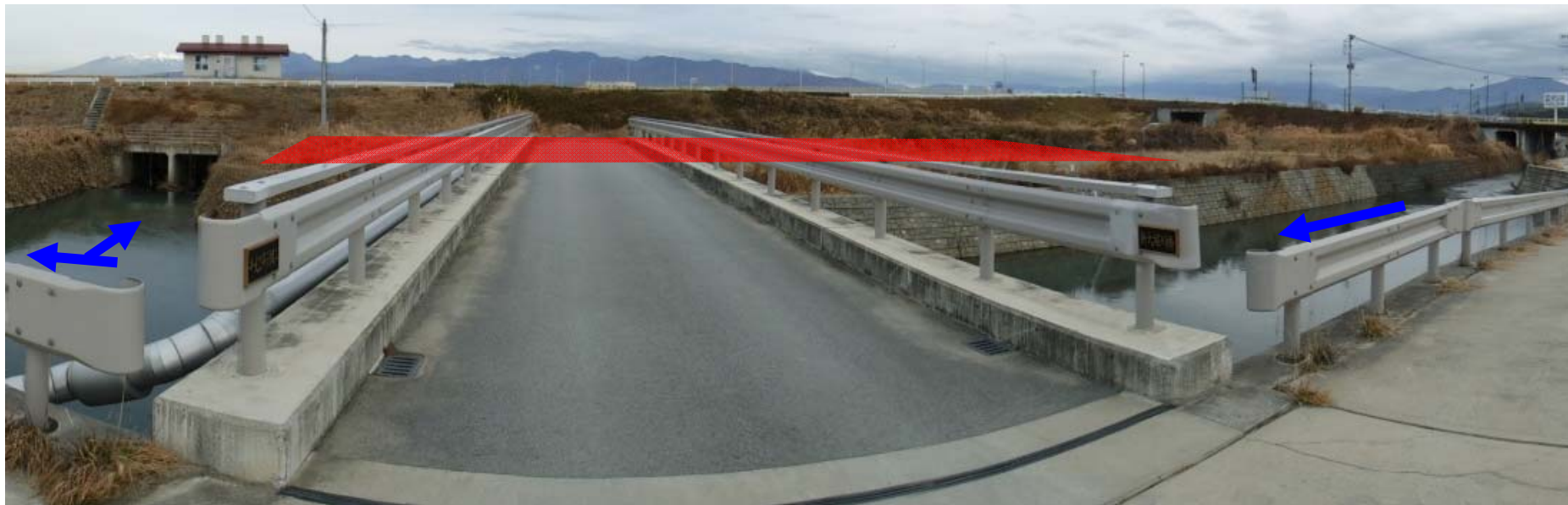
写真① 排水機場建設予定地
