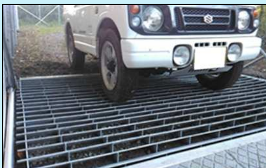
イノシシ・シカの侵入を防止する ブラインド型グレーチング技術
