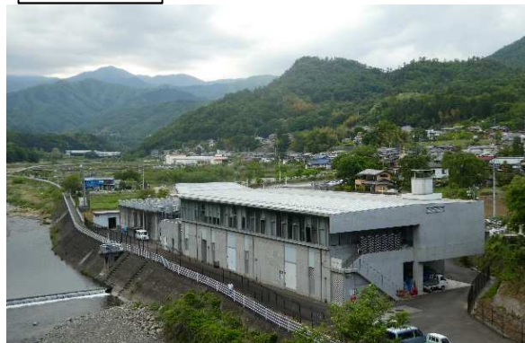
①水道施設 (東部地域広域水道企業団)
