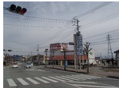
【写真①】 現道の状況
