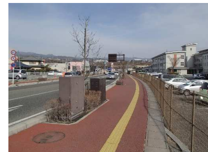
【写真②】 接続する整備済み区間
