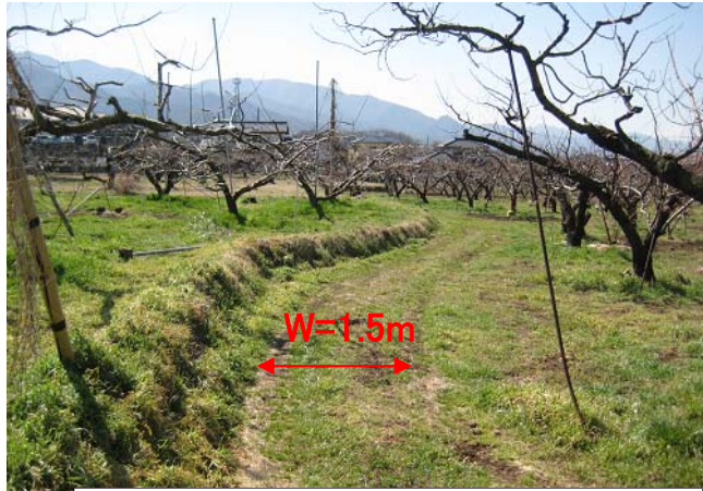
① 未整備で狭小な農道は農作業車両の通行に支障があり作業効率が悪い。
