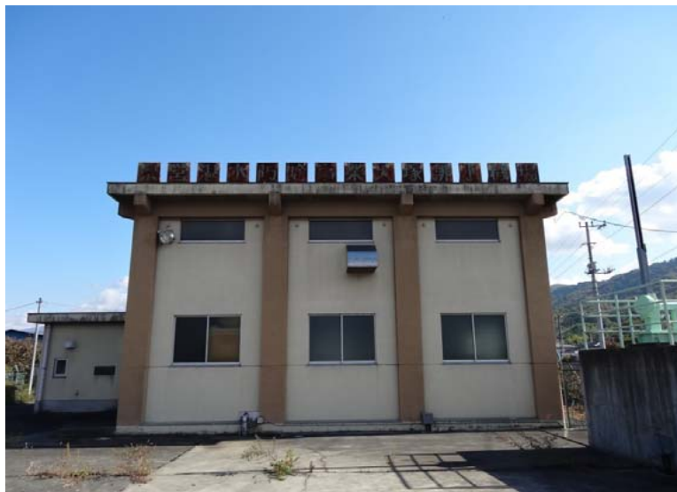
①大塚排水機場の全景
