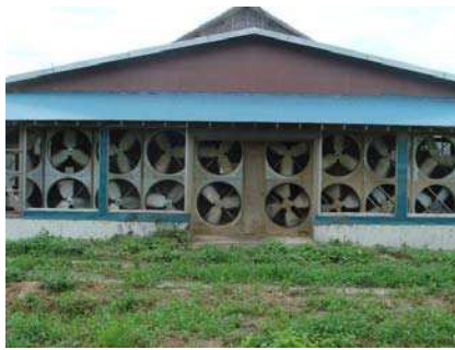
牛舎壁面の換気扇
