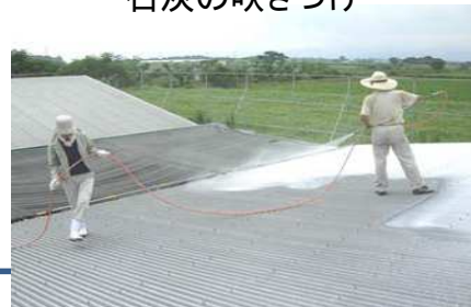
石灰の吹きつけ
