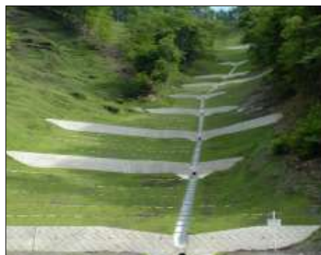
山腹工による崩壊地の復旧状況
