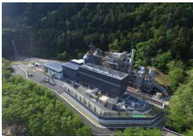
木質バイオマス発電所（大月市内）
