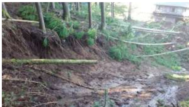
豪雨による被災状況
