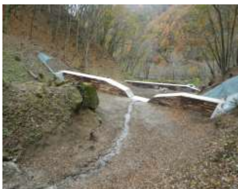
治山ダムの設置
