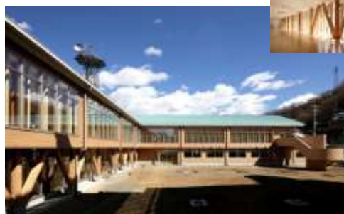
H28 大月短期大学校舎 木材量 600 m 3 （県産材 557 m 3 ）
