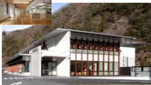
H27 早川町庁舎 木材量 142 m 3 （県産材 141 m 3 ）
