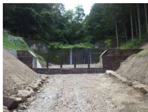
流木捕捉式治山ダムの設置による流木対策
