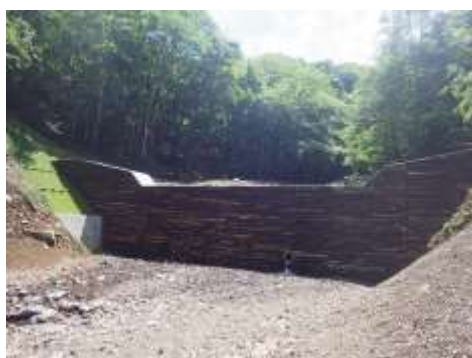
治山ダム設置による土砂流出防止対策
