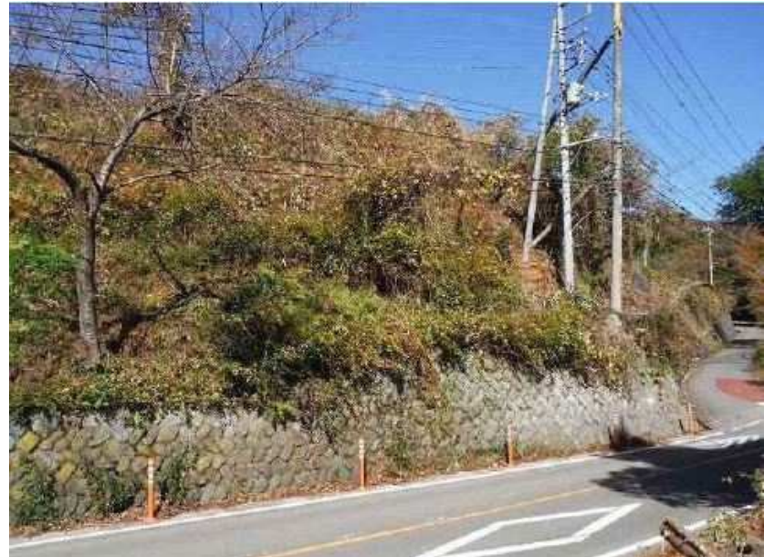
【写真②】 道路防災点検の要対策箇所を含んだ道路北側斜面の状況
