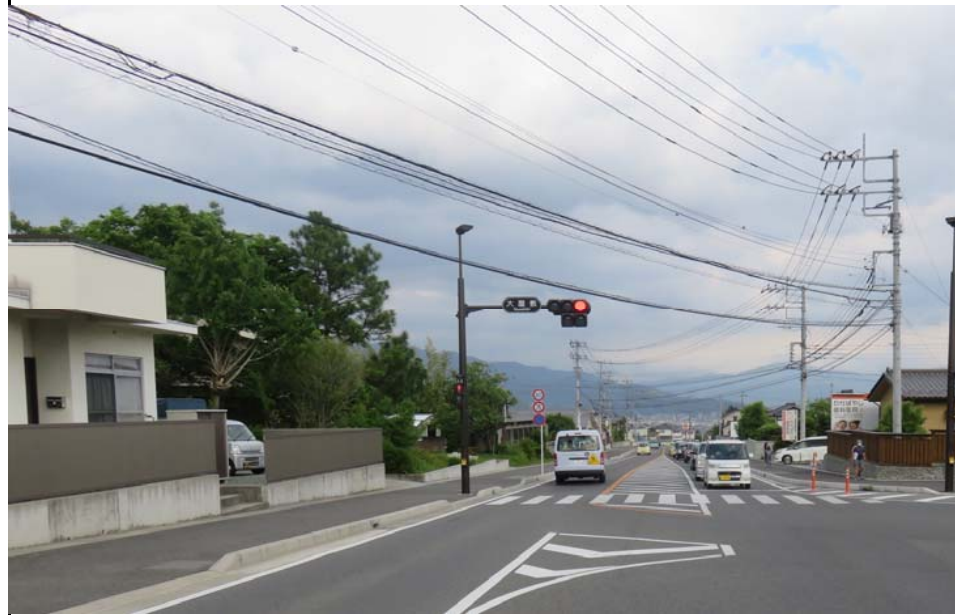
【写真①】 電線、電柱の状況
