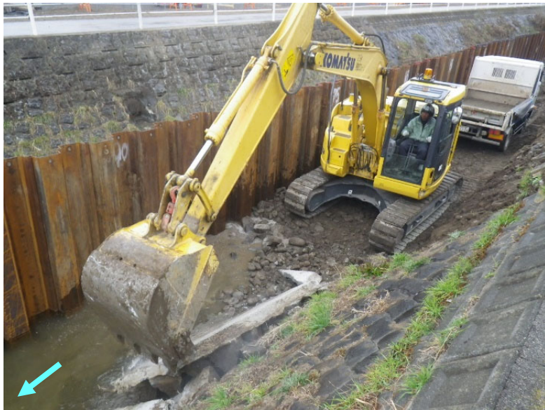
作業スペースの狭小状況と鋼矢板による半川締切の状況
