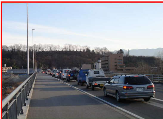
武田橋改良前の様子（平成19年1月、西側から撮影）
