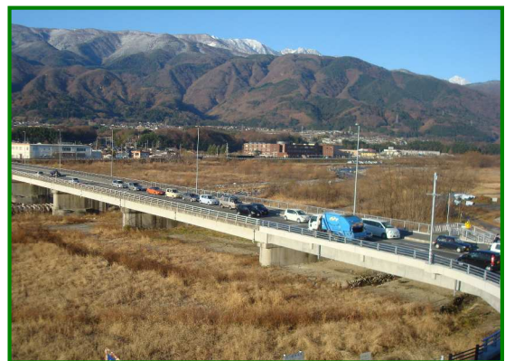
武田橋改良後の様子（平成20年12月、東側から撮影）
