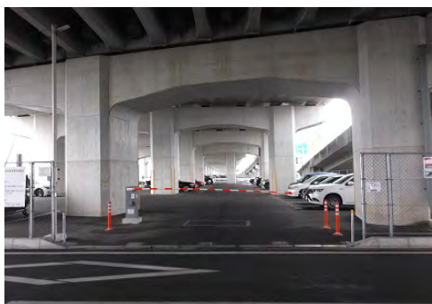
新山梨環状道路の桁下空間を利用したP&R駐車場
