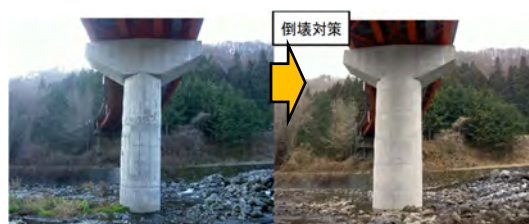
写真 耐震補強工事(橋脚巻立て)
