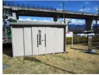
非常時に使用する資材等を保管
