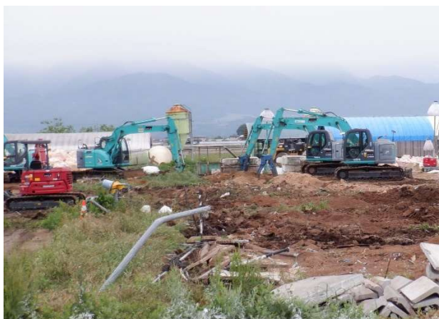
《掘削地での作業》
