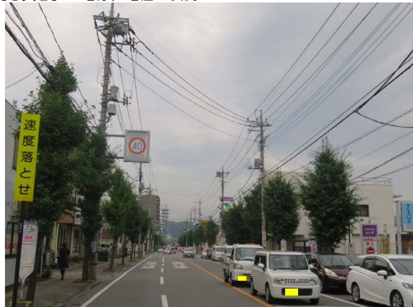
【写真①】 電線、電柱の状況
